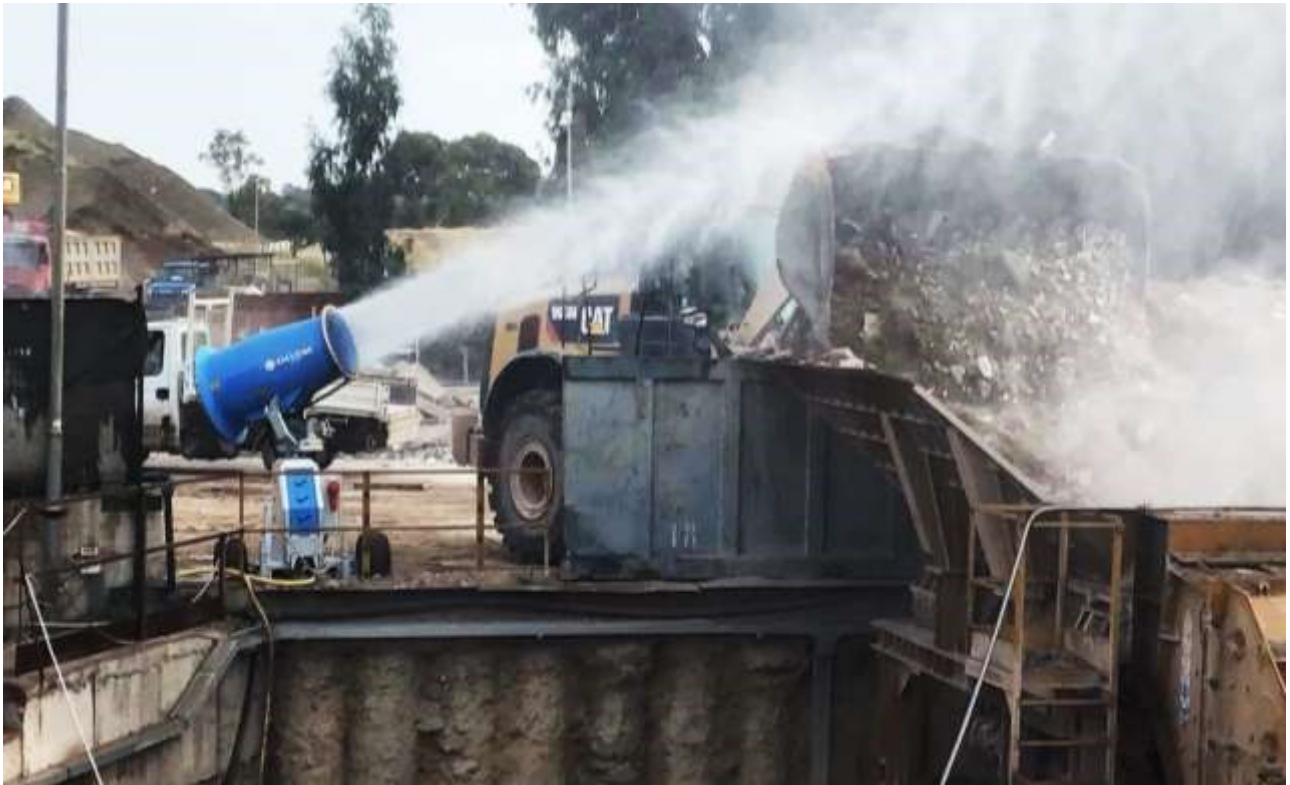
Azione di cannone nebulizzatore in fase di movimentazione macerie
